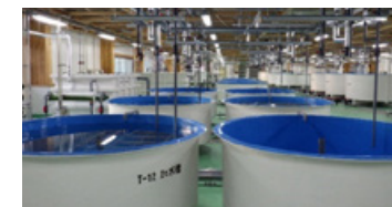
陸上養殖設備
