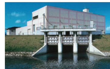
雨水排水機場 /下川原雨水ポンプ場
